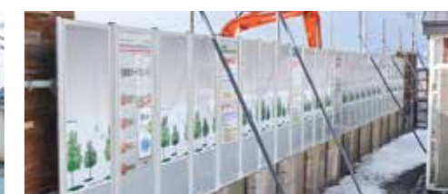
建設現場の壁面
