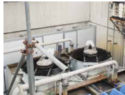
既存のサイレンサーを取り外します。
