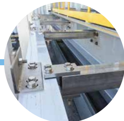
既設のH鋼にフレームを接続。
