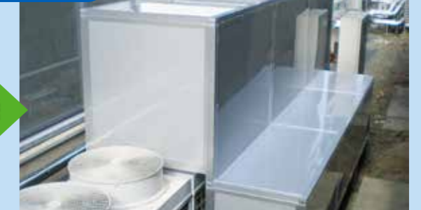
55dB 室外機の性能を損なうことなく、吸音パネルが騒音低減に成功。
