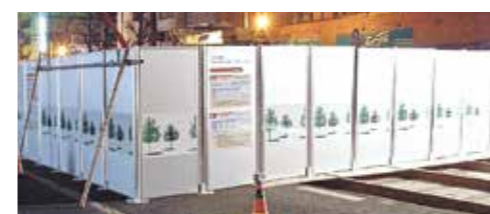
夜間の道路工事
