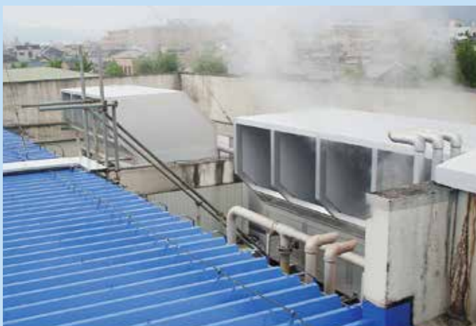
吸音パネルなので、開口部を設けても騒音低減が可能です。
